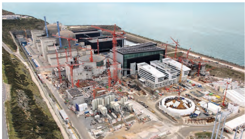
■ Le chantier EPR de Flamanville 3 (Manche).
