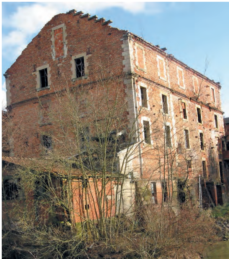
■ Bâtiment principal de l'ancienne usine Orflam-Plast, à Pargny-sur-Saulx (Marne).
