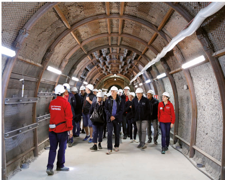
Un expert de l'IRSN présente les recherches en cours dans la galerie Ouest - 2008 du tunnel de Tournemire.
