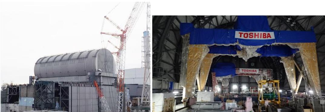
Figure 2 : Vue de la structure recouvrant le bâtiment du réacteur n°3 (état en février 2018) et des moyens de manutention du combustible qui y sont implantés - Source TEPCO.
