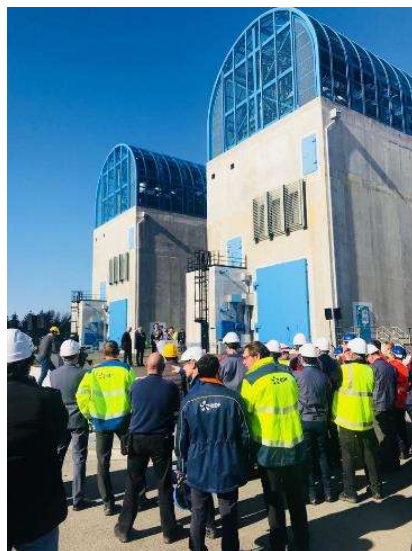
Mise en exploitation des Diesels d'Ultime Secours
