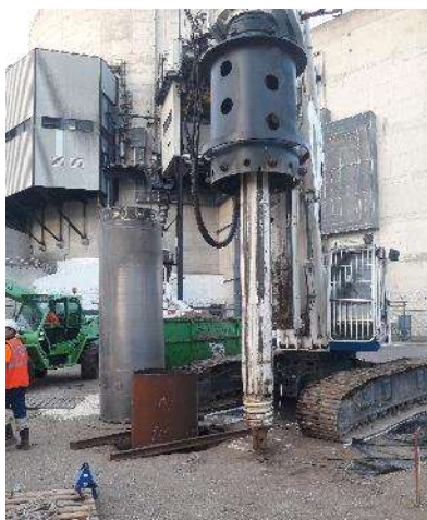
Forage pour la Source d'eau ultime de BEL
