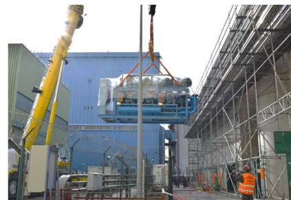
AGRESSION GRAND CHAUD Remplacement augmentation performances groupes froids
