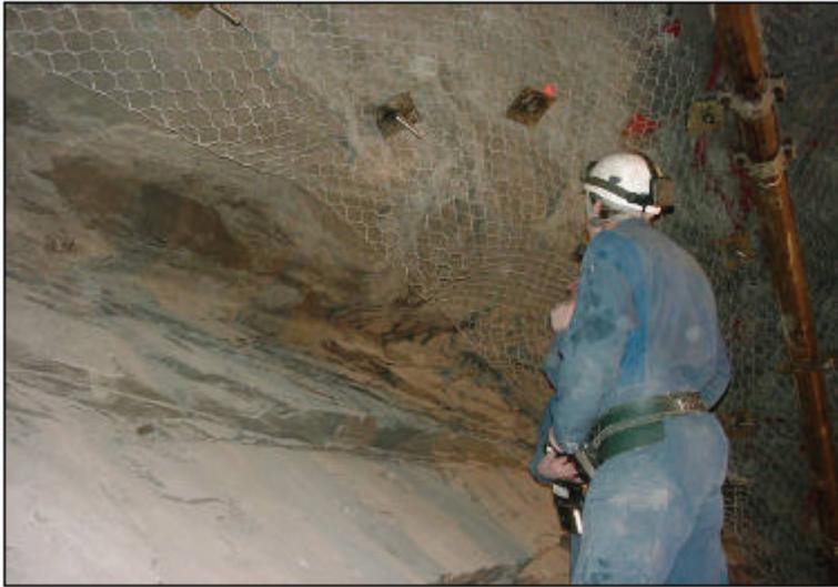
Trace des fractures de cisaillement en paroi de galerie.
