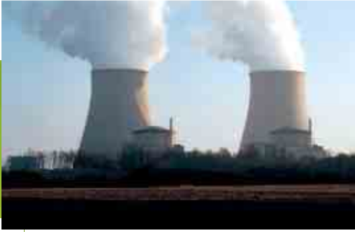
Power plant at Nogent-sur-Seine (Aube).
