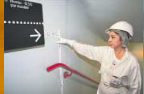
Inondations de décembre 1999 à l'intérieur de la centrale du Blayais : indication du niveau de la montée des eaux dans le local qui abrite l'échangeur d'aspersion dans le bâtiment combustible.
