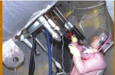
Intervention sur des tubes du générateur de vapeur en centrale.
