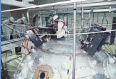
Travaux sur la chambre d'expériences de la ligne d'intégration laser, prototype du futur Laser Mégajoule, le Barp (Gironde).
