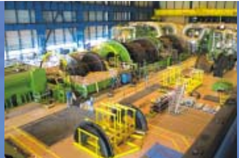
Centrale de Civaux (Vienne).
