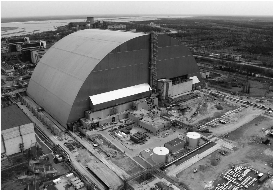
Figure 34.3. Le nouveau sarcophage une fois installé, vue prise en 2017. BERD.
