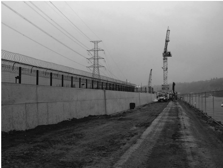
Figure 37.2. Protection périphérique du site de Tihange. Centrale nucléaire de Tihange.
