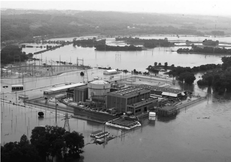
Figure 37.5. Au mois de juin 2011, une crue du Missouri a entraîné l'inondation de la centrale de Fort Calhoun aux États-Unis. Nati Harnik/AP/SIPA.
