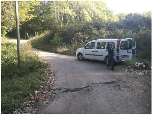
Figure 4 : Rupture de surface au séisme du Teil observée par la mission post sismique RESIF - Crédit photos : JF RITZ (Géosciences Montpellier), S BAIZE (IRSN), C LARROQUE (GéoAzur), M Ferry (Géosciences Montpellier), L AUDIN (ISterre)
