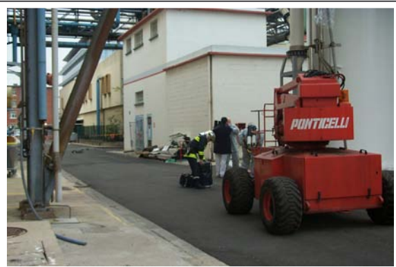
Préparation des intervenants : Les deux intervenants s'équipent avec l'aide des pompiers
