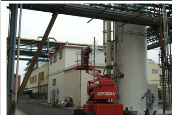
Préparation de l'intervention : préparation de l'installation afin d'accéder à la partie incriminée
