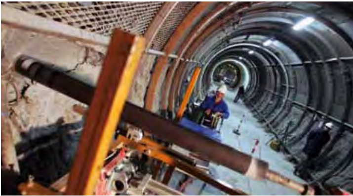
Forage à sec dans une galerie du tunnel expérimental de Tournemire (Aveyron).
