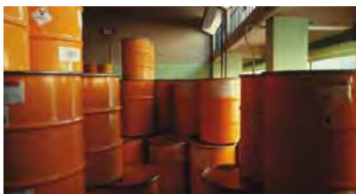
Entreposage de déchets dans un hall de la centrale de Brennilis (EDF).
