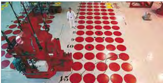
Entreposage de déchets vitrifiés. Vue de dessus des puits (Marcoule).
