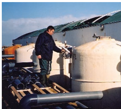
Contrôle de radioactivité des groupes de filtres à eau.
