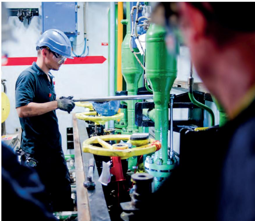
À la centrale du Blayais (Gironde), l'inspection contrôle des interventions réalisées par des agents EDF sur les robinets et des diaphragmes lors de la modification du système d'alimentation de secours en eau des générateurs de vapeur (ASG).
