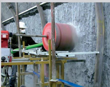
**Industriels des secteurs nucléaire, minier ou BTP**, le nouveau procédé de forage de grand diamètre développé par l'IRSN peut vous intéresser. Contrairement aux dispositifs classiques, celui-ci ne modifie pas les caractéristiques mécaniques du matériau foré. Il permet des forages de 40 à 70 cm de diamètre sur plusieurs dizaines de mètres de profondeur. L'IRSN l'a mis au point pour ses besoins d'études géotechniques,
