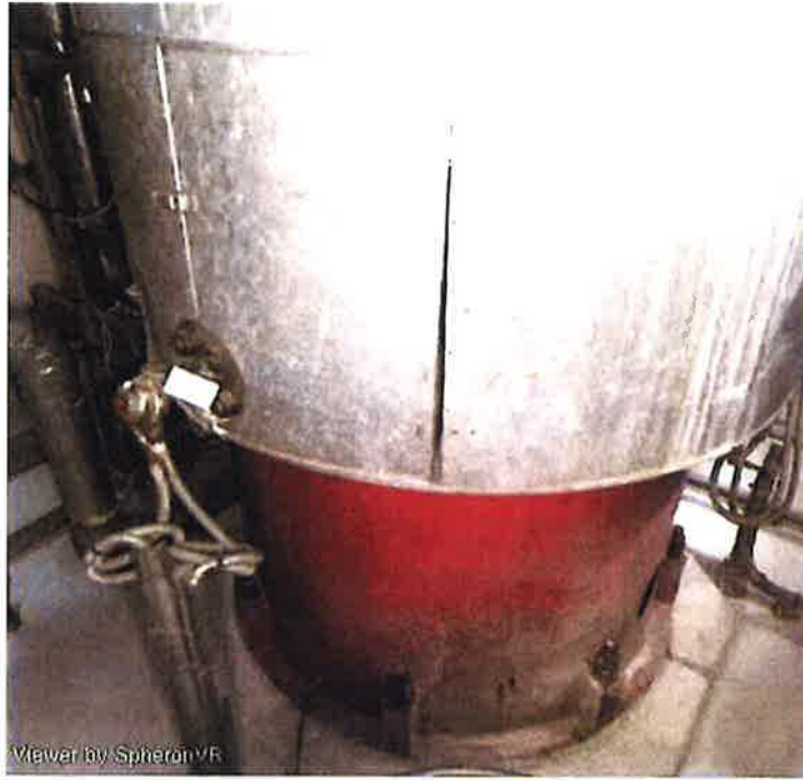
figure1 Ancrages d'un réservoir RIS 004 BA.
