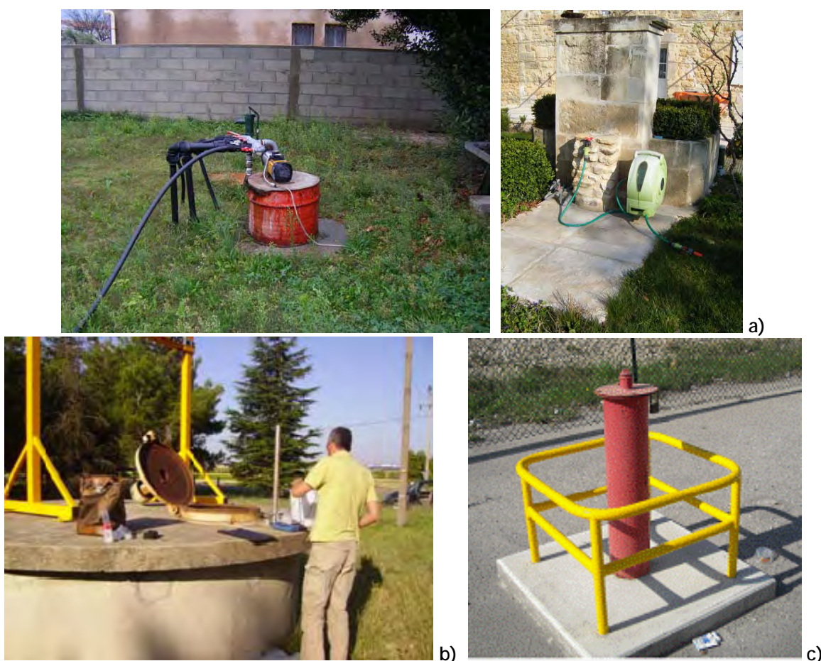
Figure 18 : Exemples de captages dans la plaine du Tricastin. a) AEP particuliers ; b) AEP collectif ; c) piézomètres site
