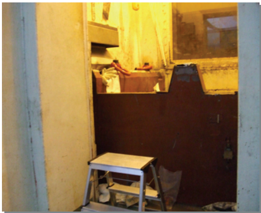
Vue de l'enceinte THA n°2 depuis la porte en zone arrière
