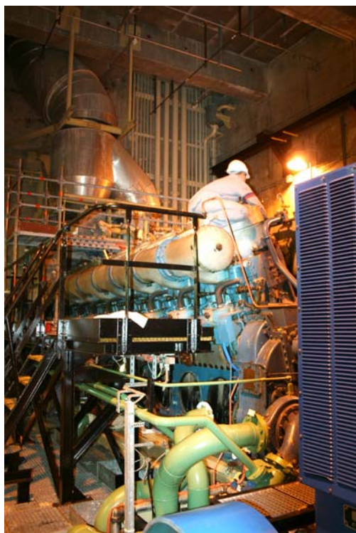
Intervention de maintenance sur un groupe électrogène à moteur diesel
