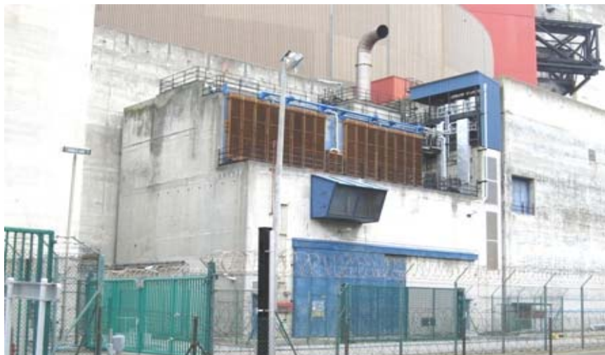
Bâtiment abritant un groupe électrogène à moteur diesel
