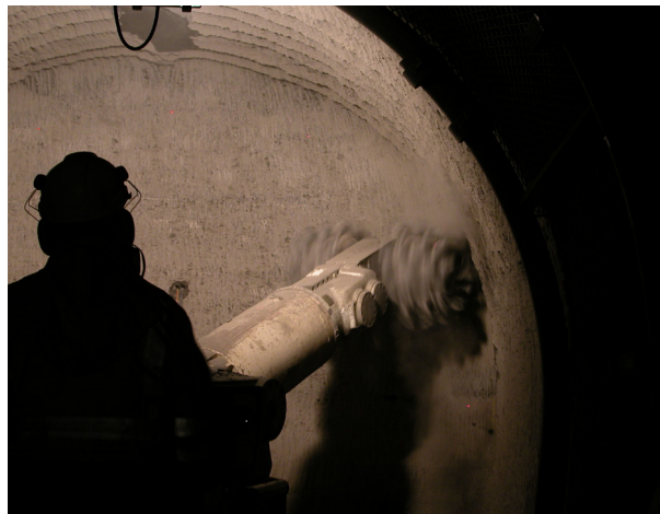
Machine à attaque ponctuelle utilisée pour le creusement des galeries.
