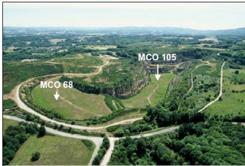
Figure 2 : Vue aérienne du site de Bellezane (d'après BDE, AREVA NC, 2004)
