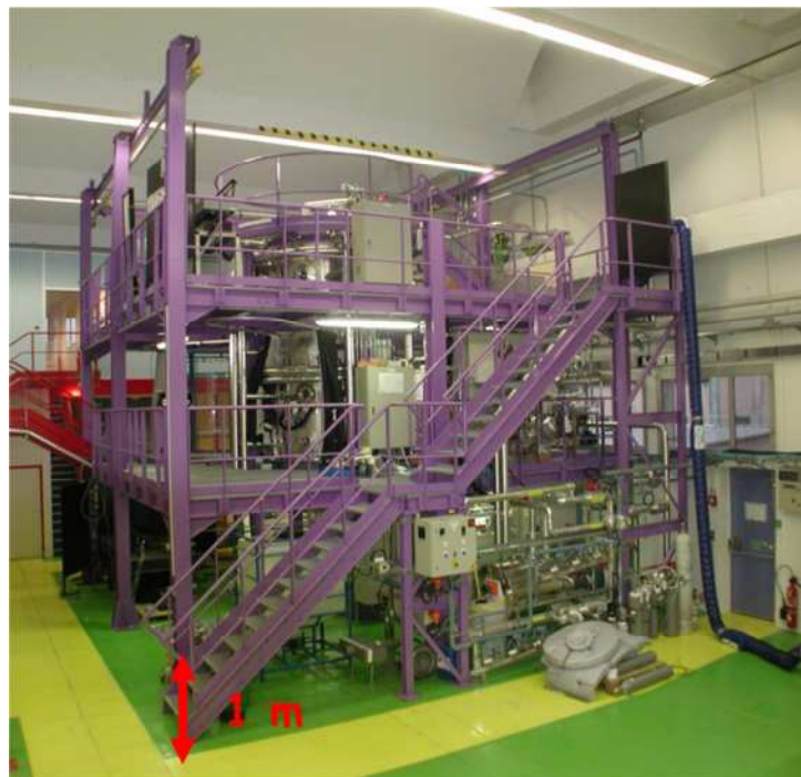
Figure 2. Vue générale de la plate-forme d'essais TOSQAN
