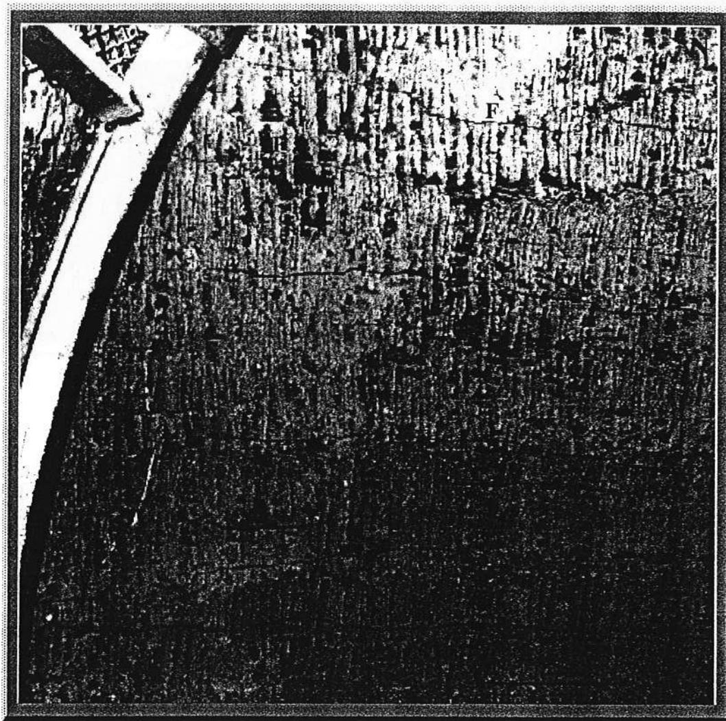
FIG. 3 – Fissuration au front de taille de la galerie Ouest
