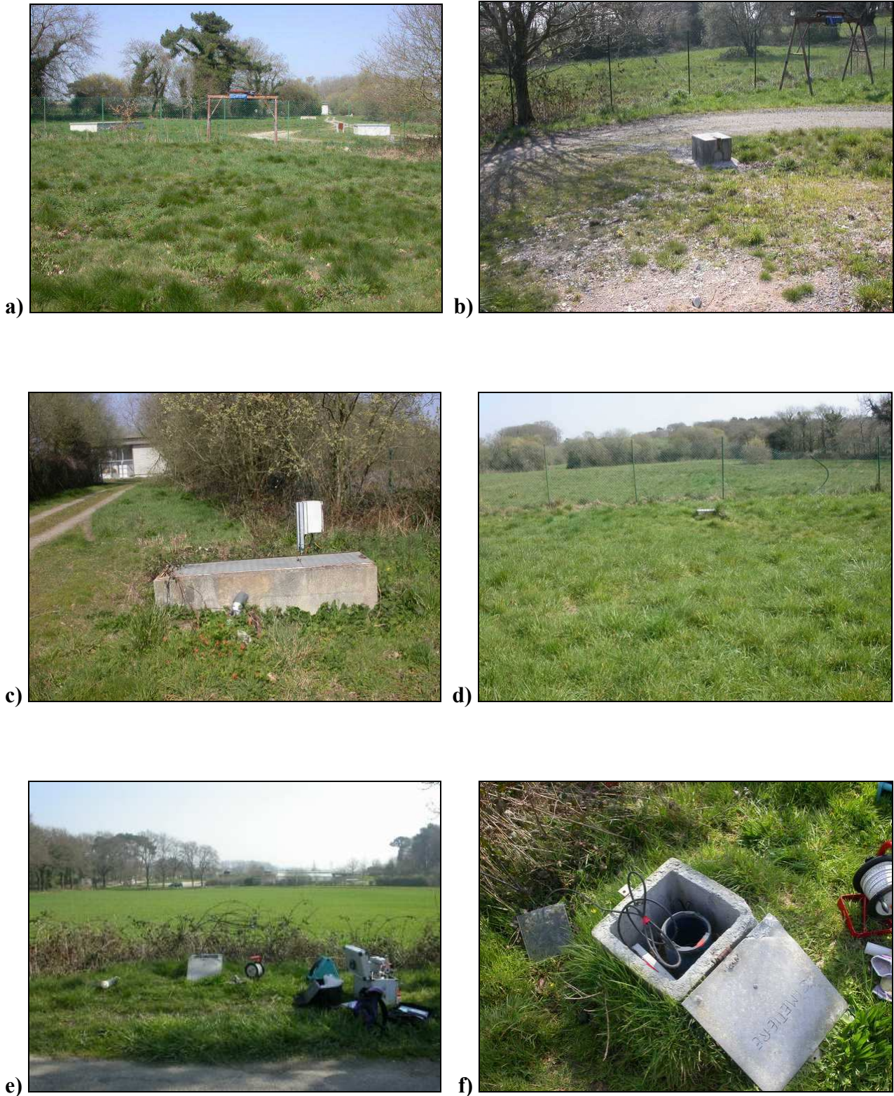
Figure II.6 :Photos du site de Kermadoye : a) périmètre de protection immédiat autour de la zone de pompage, b) forage F28 à l'intérieur du périmètre, c) au premier plan : forage F29 équipé d'un système de pompage, en arrière plan : hangar contenant le système d'exploitation du captage AEP et le forage Pe, d) piézomètre mF2 et prairies attenantes e) forage F9 localisé entre la route départementale et une surface agricole cultivée f) "tête de puits" du forage F9.
