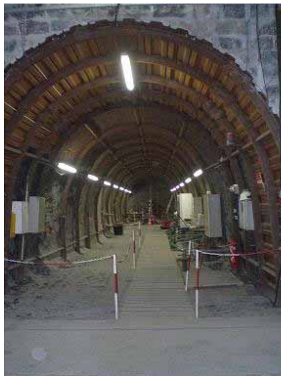
Figure II.9. Galerie Est-96 (vue du côté Ouest à partir du tunnel).
