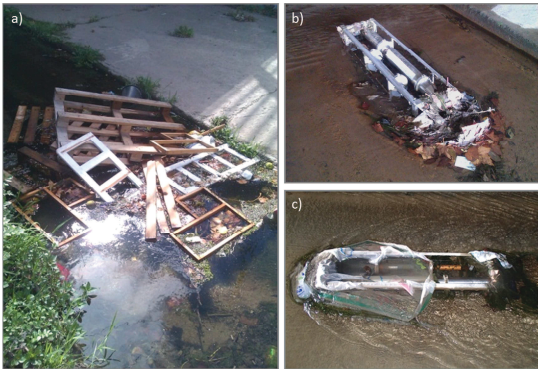
Figure III- 31 a), b) et c) : Cage d'instrumentation de l'Eygoutier encombrée de déchets.
