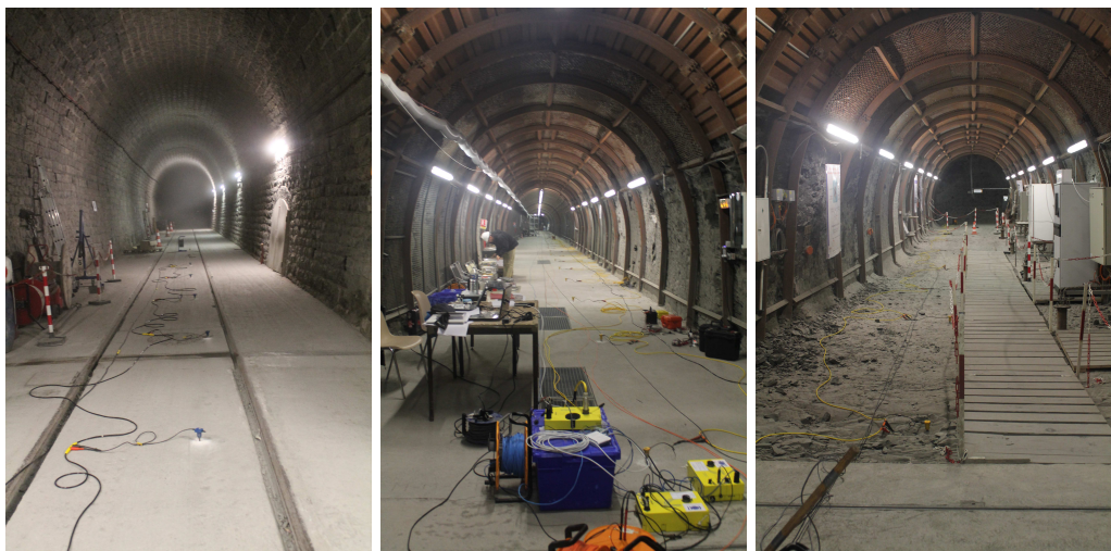
FIGURE 6.8 – Photo de l'installation des géophones dans les ouvrages souterrains, avec (a) les géophones situés dans le tunnel, (b) les géophones dans la galerie Ouest, et (c) les géophones placés directement dans la couche argileuse de la galerie Est.
