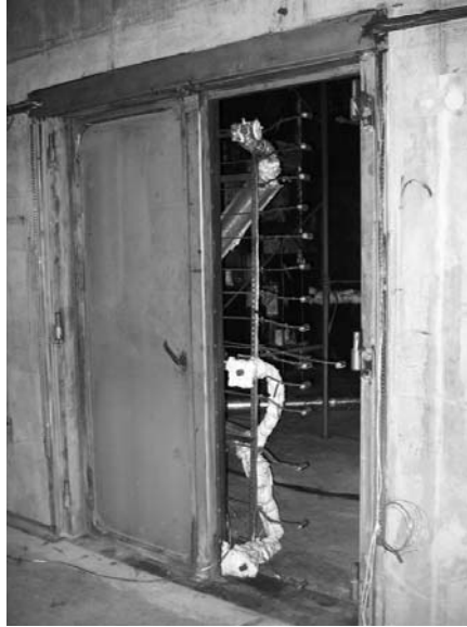
Figure D-7: Photographie de la porte entre le local "source" et le local "cible"
