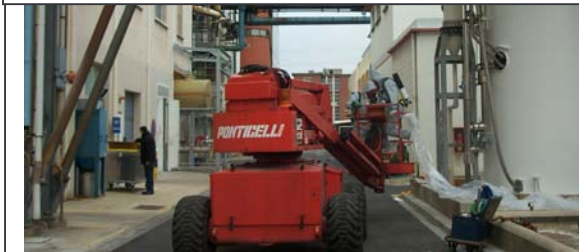
Les deux intervenants montent dans la nacelle
