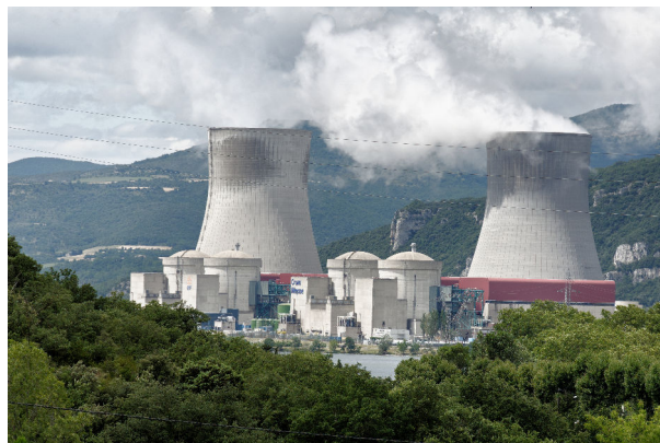
FIGURE 1: Photo de la centrale de Cruas-Meysse.
