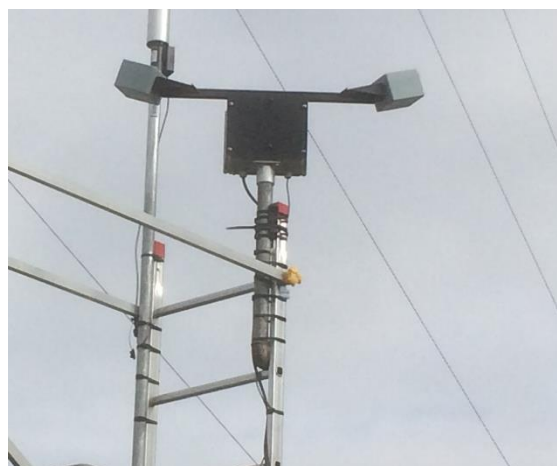
Figure 3.2 - Visibilimètre installé sur site d'Houdelaincourt.
