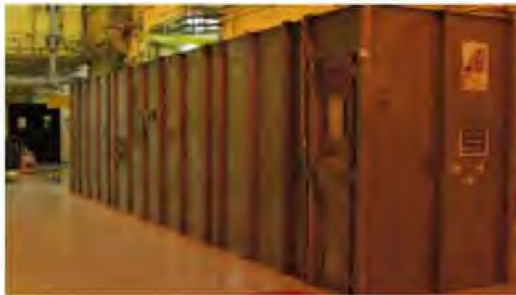
Figure 1.3 : sas d'intervention en parois métalliques
