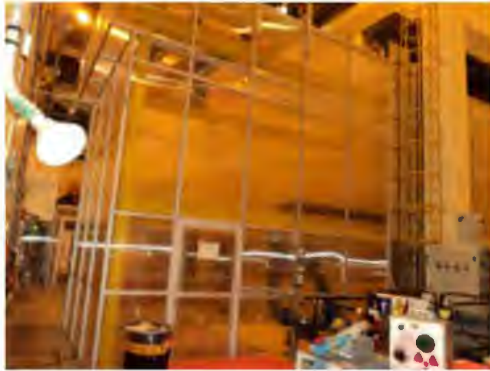
Figure 1.2 : sas d'intervention à parois rigides transparentes
