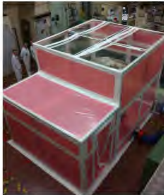
Figure 1.1 : sas d'intervention à parois souples
