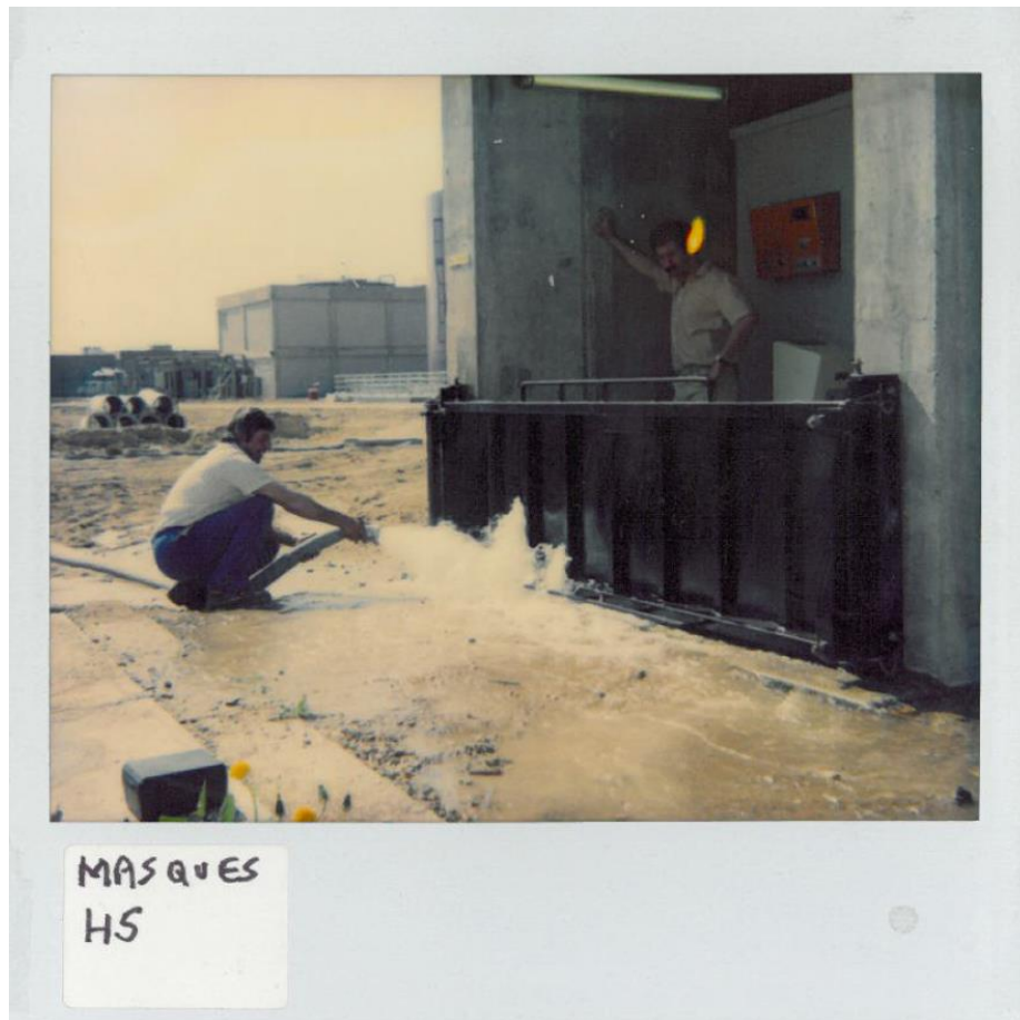
Figure 56 : Le test d'un batardeau, EDF 1987
