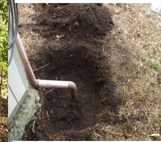
Enlèvement d'un « point chaud » en bas de gouttière
