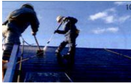
Nettoyage par eau sous pression et brossage des murs et toitures, ponçage éventuellement
