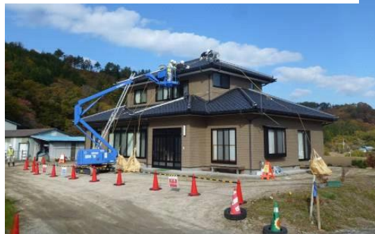
Nettoyage par eau sous pression et brossage des murs et toitures, ponçage éventuellement
