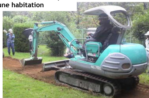
Enlèvement d'un « point chaud » en bas de gouttière
