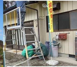
Nettoyage d'une tuyauterie d'évacuation
