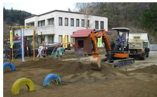
Enlèvement du sol d'une cour d'école
