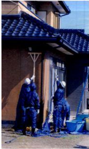
Nettoyage par eau sous pression et brossage des murs et toitures, ponçage éventuellement
