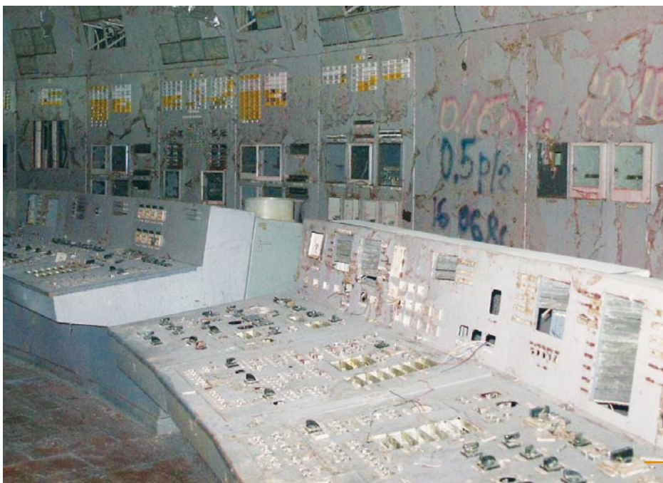
Blick in die zerstörte Warte des Blocks 4
