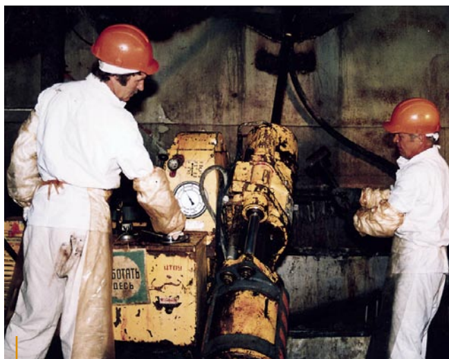
Erkundungsbohrung auf der Ebene 9
