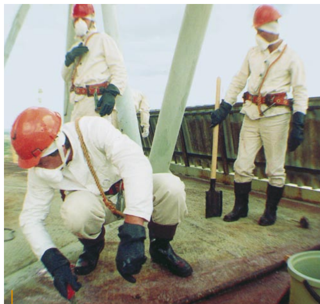
Dekontaminationsmaßnahmen auf dem Dach des Sarkophags
