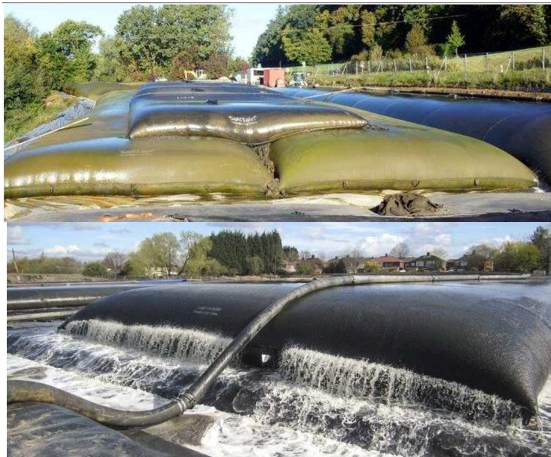
Figure 2. Entreposage des géotubes et remplissage des géotubes (Source AREVA NC)
