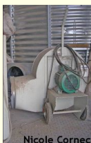
Ventilateur d'un silo à céréales
