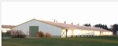
Bâtiment d'élevage de volailles fermé
