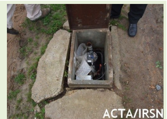
ACTA/IRSN Système de fermeture / ouverture de l'irrigation
