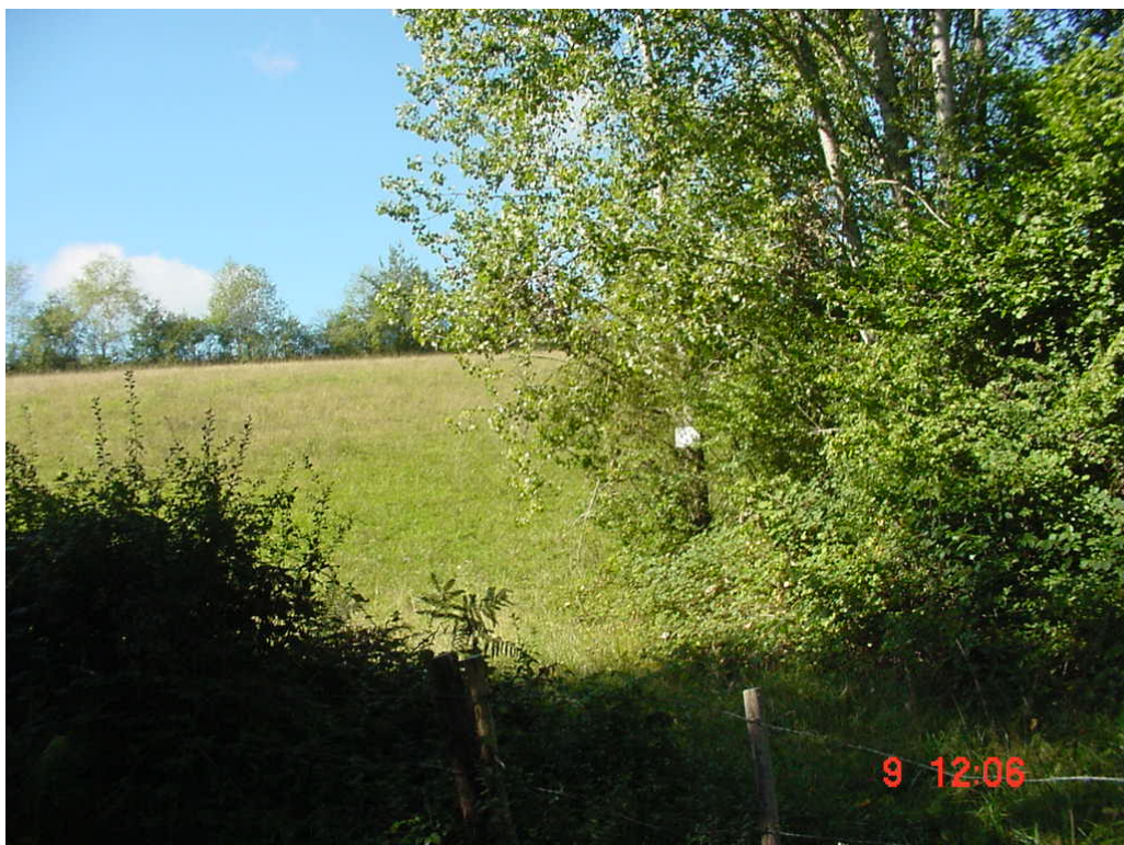
Photo 4 : Partie nord de la digue vue de la route bordant l'est du site
