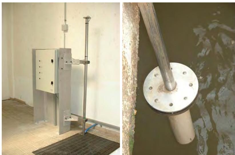
*Figure 34 : Photos d'une station Télhydro (vue générale et détaillée de la sonde)*
