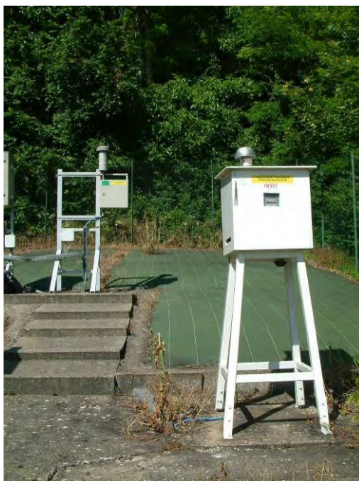
Figure 41 : Photo de la cabine aérosols IRSN implantée sous les vents dominants du CNPE de Belleville (AS1)
