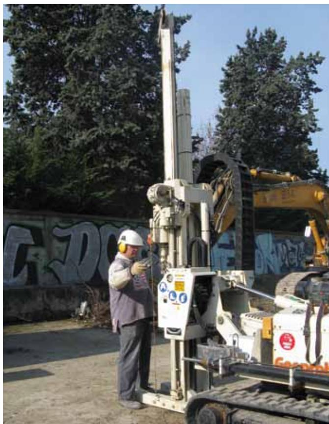
FIGURE VII.9 Forage de prospection sur le site Charvet.
