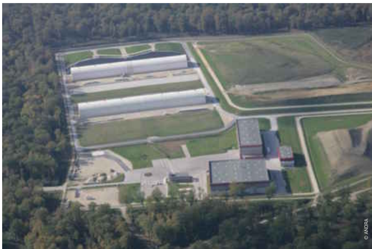
Centre de stockage TFA de Morvilliers.
