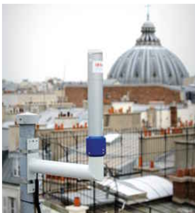
FIGURE 1 / SONDE DE MESURE EN CONTINU DU DÉBIT DE DOSE GAMMA AMBIANT DU RÉSEAU TÉLÉRAY DE L'IRSN (PHOTO DU HAUT) ET DOSIMÈTRE RPL INSTALLÉ SUR LE SITE DE CADARACHE (PHOTO DU BAS)
