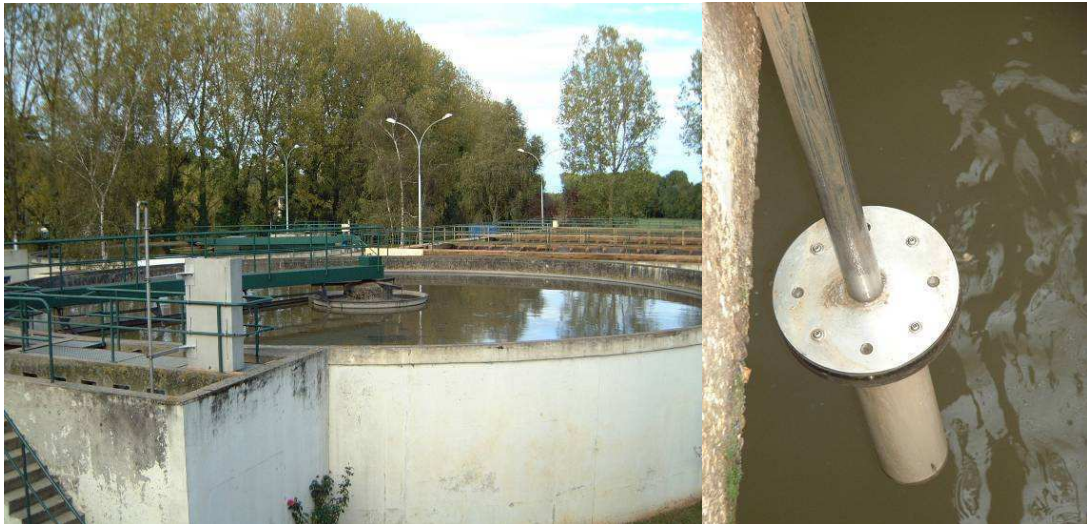
Figure 62 : Photos d'une station Télhydro (vue générale et détaillée de la sonde)
