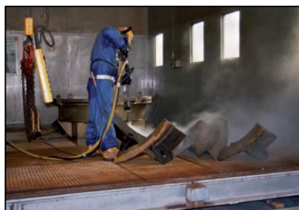
Figure 6.16 - Opérations de décontamination mécanique ou chimique effectuées à la centrale de Greifswald (Allemagne)
