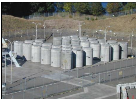
Figure 6.7 - Entreposage du combustible usé de la centrale démantelée de Trojan (USA)
