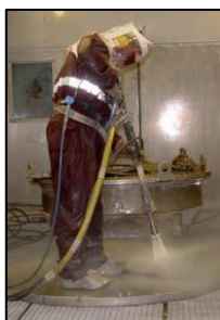
Figure 6.16 - Opérations de décontamination mécanique ou chimique effectuées à la centrale de Greifswald (Allemagne)
