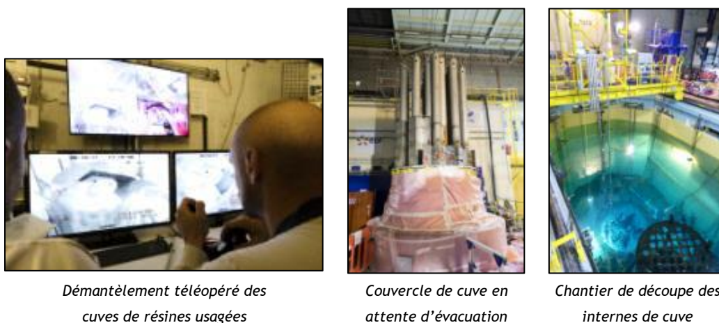
Figure 4.1 - Démantèlement du réacteur Chooz A
