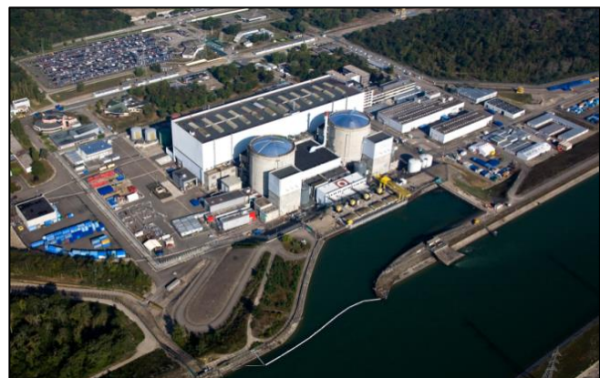
Figure 6.4 - Unités REP 900 MWe CP0 (CNPE de Fessenheim)
