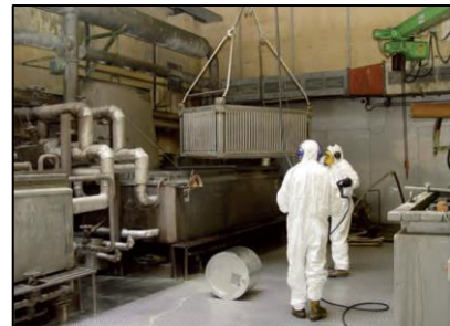
Figure 6.16 - Opérations de décontamination mécanique ou chimique effectuées à la centrale de Greifswald (Allemagne)
