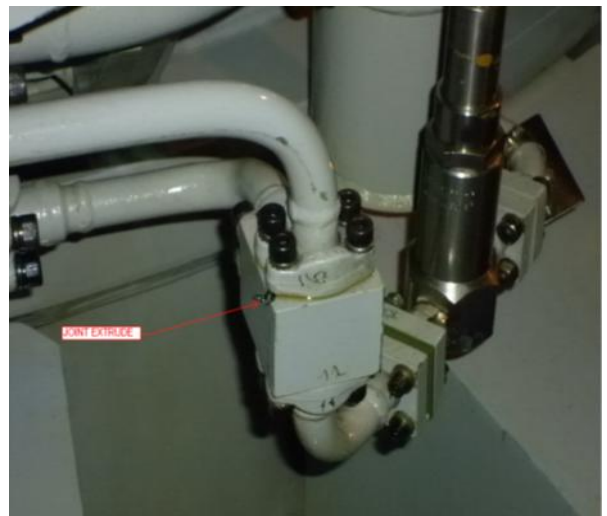
Photographie 2 : Joint sorti de sa position initiale
