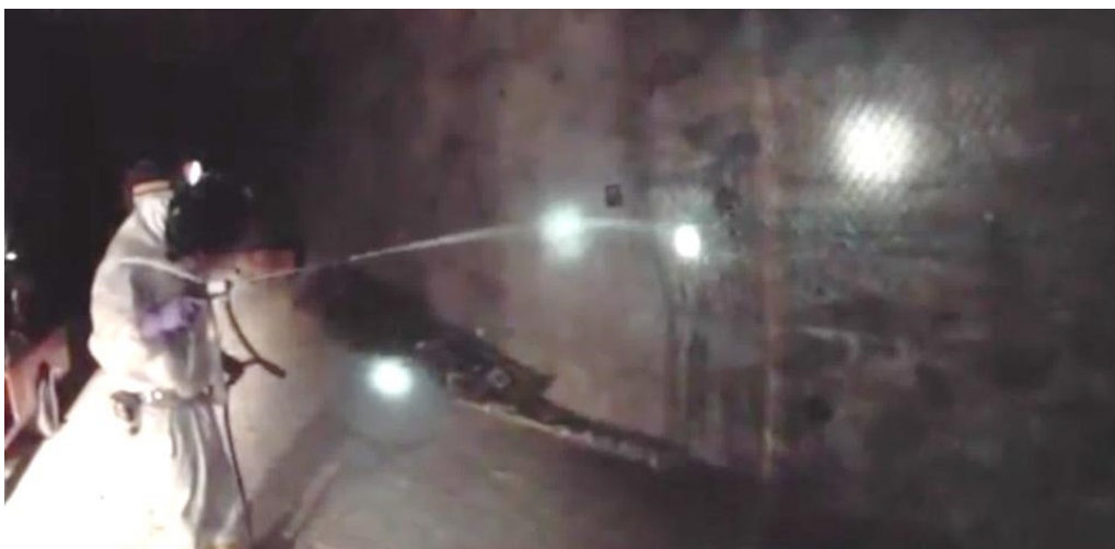
Figure 43 : Décontamination par pulvérisation (source DOE, mp4 [109])
