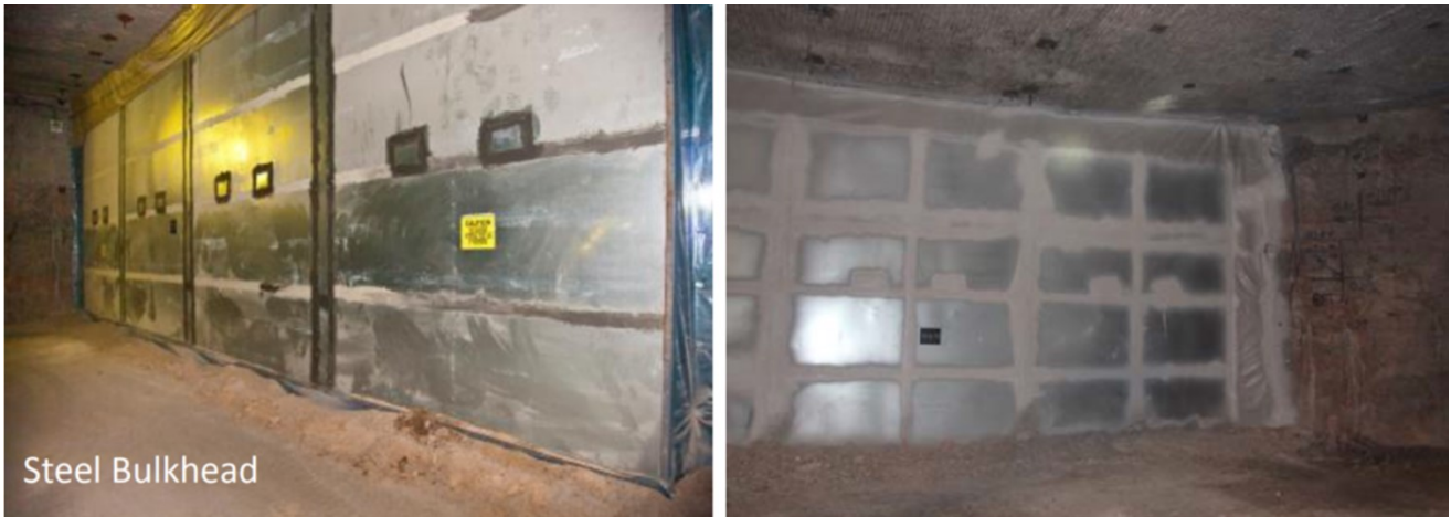
Figure 53 : Mise en place de cloison métallique dans les zones 6 et 7
