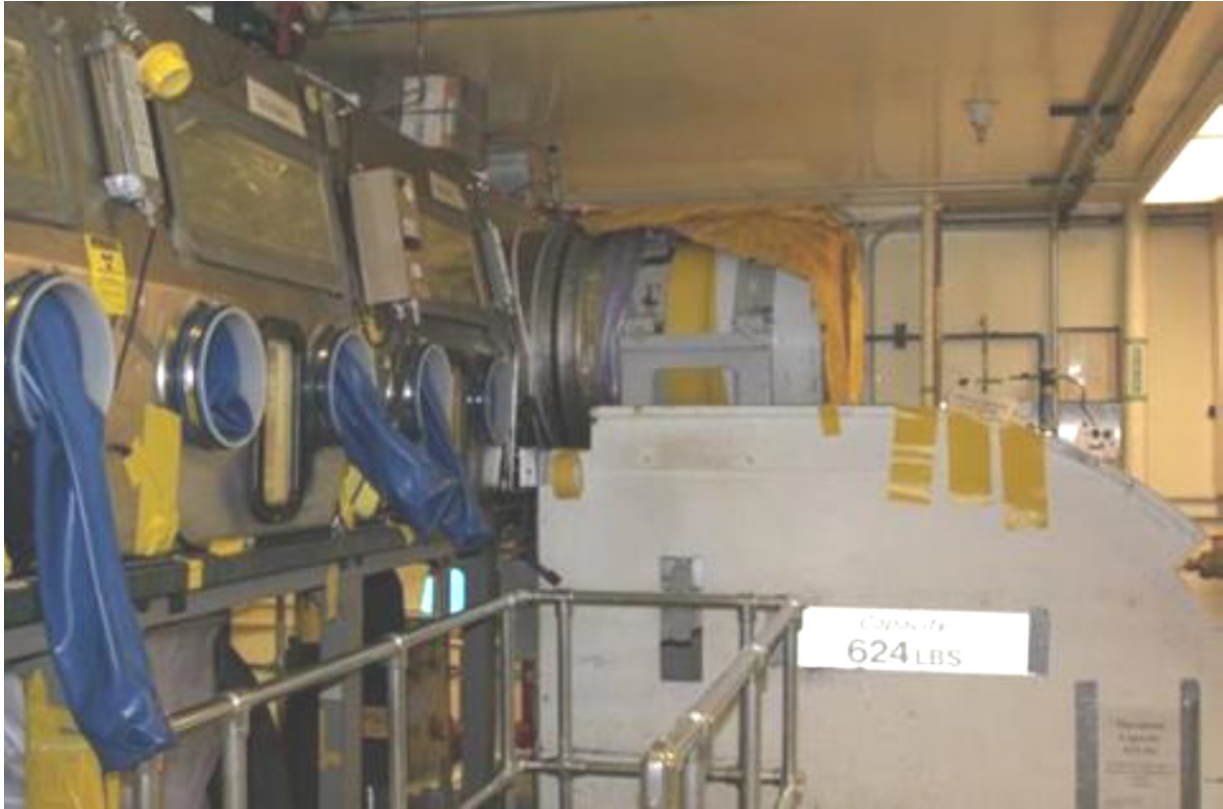
Figure 22 : Boite à gant pour la caractérisation des déchets au WCRRF (source DOE [70])
