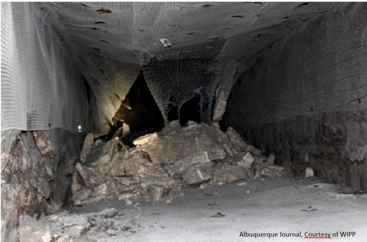
Figure 57 : Effondrement dans une galerie du WIPP (source ABQJ [304])
