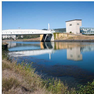
Le Canal de Donzère près du site nucléaire du Tricastin. En prévention du risque inondation, l'exploitant EDF et la Compagnie nationale du Rhône (CNR) ont entrepris depuis 2014 de gros travaux d'aménagement du canal, pour créer notamment un déversoir de crue.
