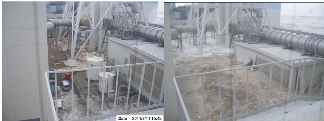
Figure 49 : Inondation de la centrale de Fukushima Daiichi le 11 mars 2011 au moment de l'arrivée de la vague (photo de gauche) et après 74 secondes (photo de droite) (source : TEPCO, "Fukushima Nuclear Accidents Investigation Report", juin 2012, attachement 3.8)
