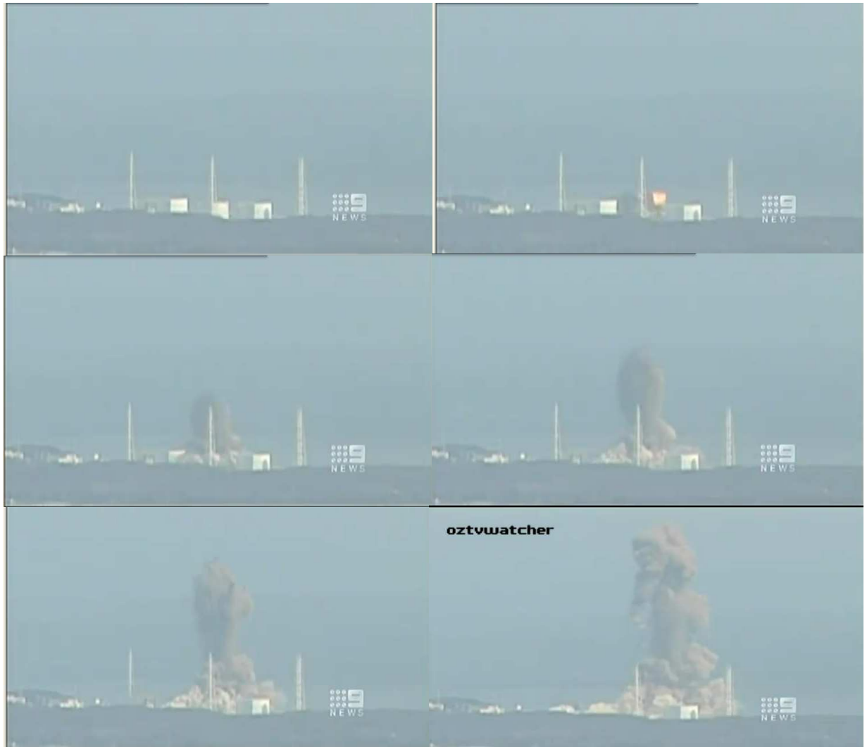
Figure 5-11 - 14 mars 11h01 : explosion dans le bâtiment du réacteur n° 3
