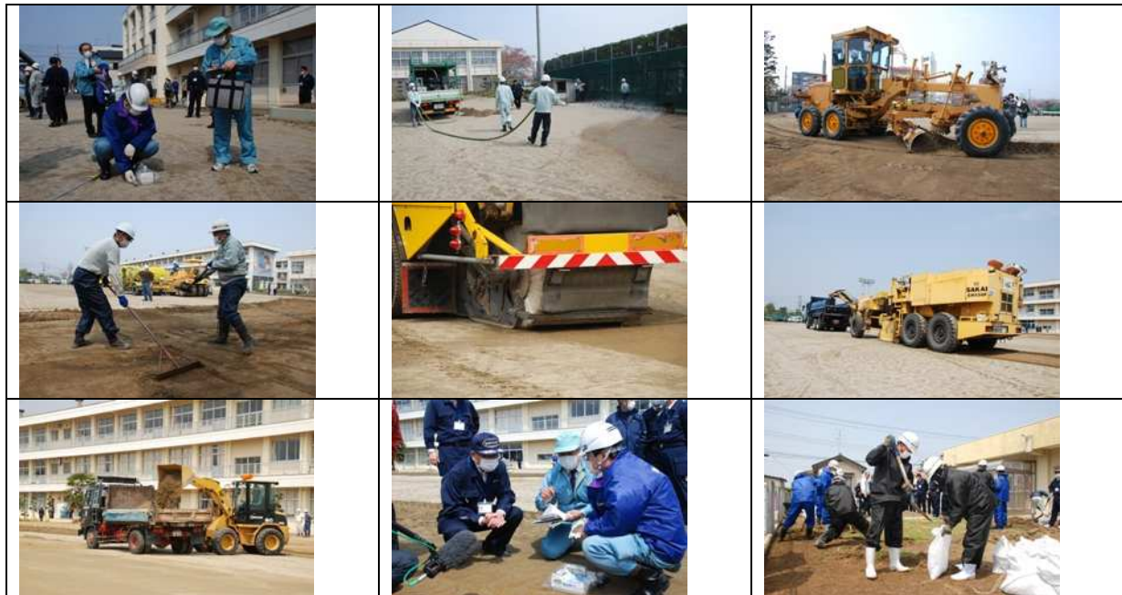
Figure 7-4 - Étapes des actions de décapage des cours d'école.
