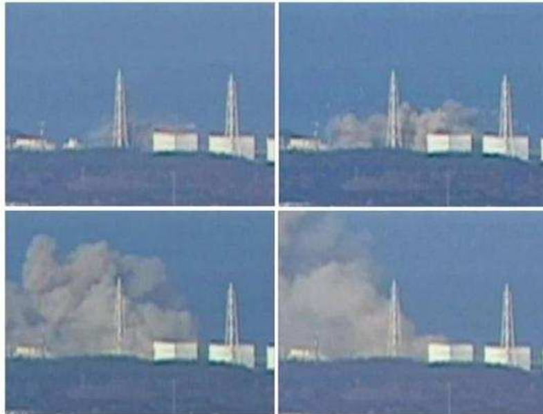
Figure 5-5 - 12 mars à 15h36 : Explosion dans le bâtiment du réacteur n° 1
