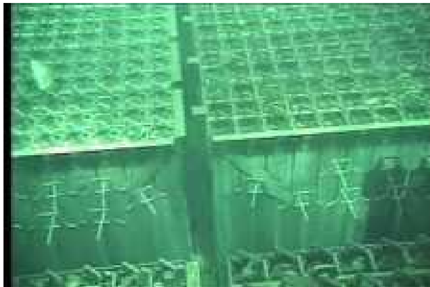
Figure 5-14 - Racks d'entreposage des assemblages usés dans la piscine n° 4 après l'accident (source TEPCO)
