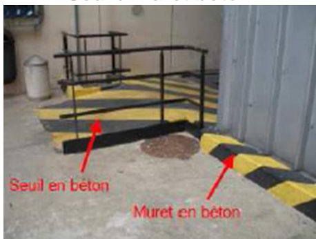
Seuil / muret béton
